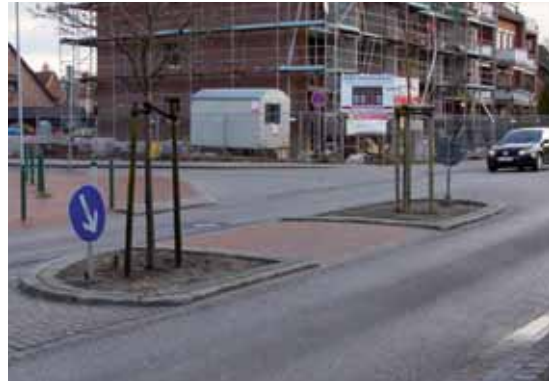
Eine Querungshilfe in der Bahnstraße
